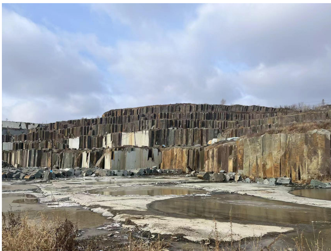
图 2.5-4 采场边坡现状
