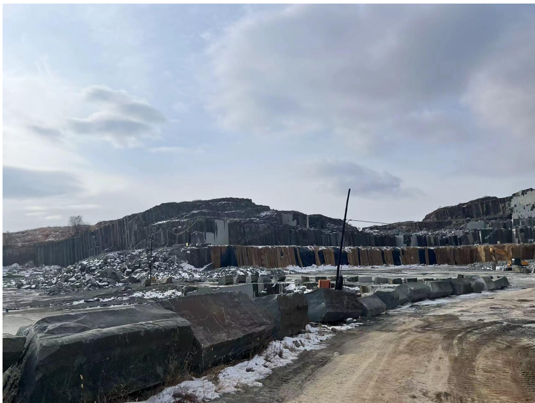
图 2.5-5 采场边坡现状
