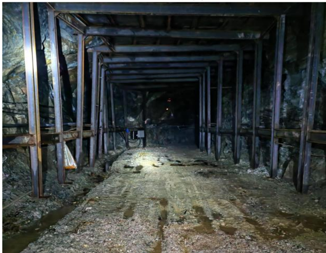
图 2.4-3 +553m 水平运输中段现状
