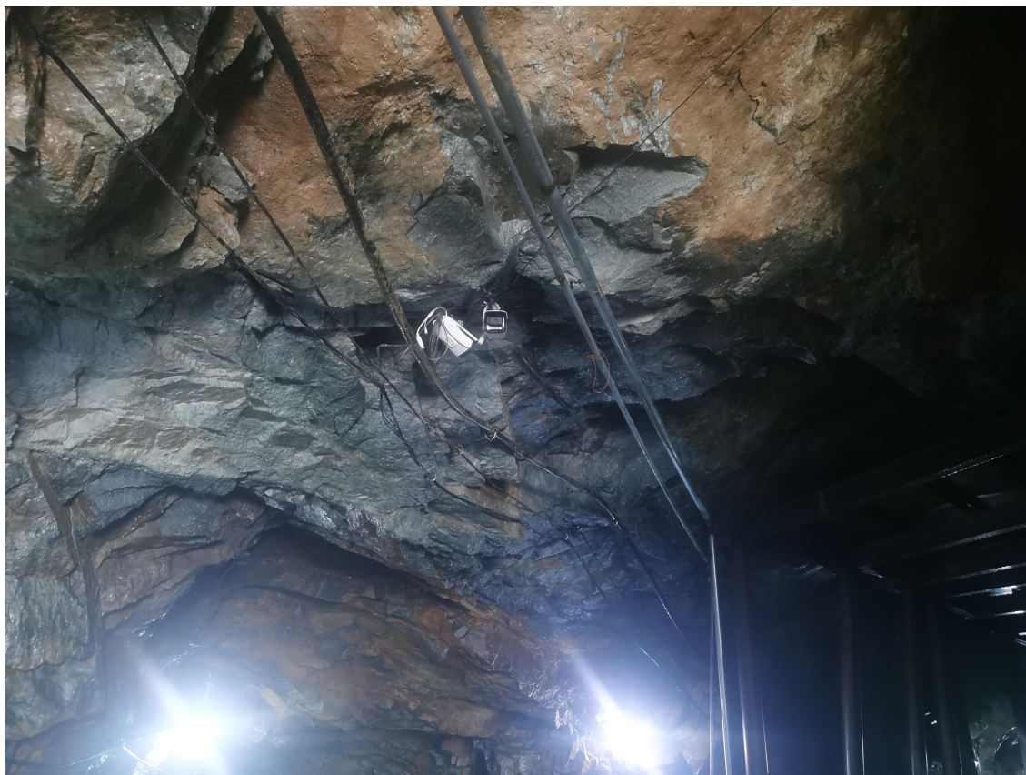
图 2.4-11 井下视频监控设施
