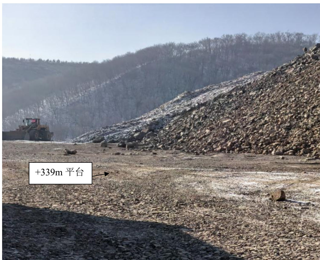
图 2.4-2 +339m 基建台阶现状
