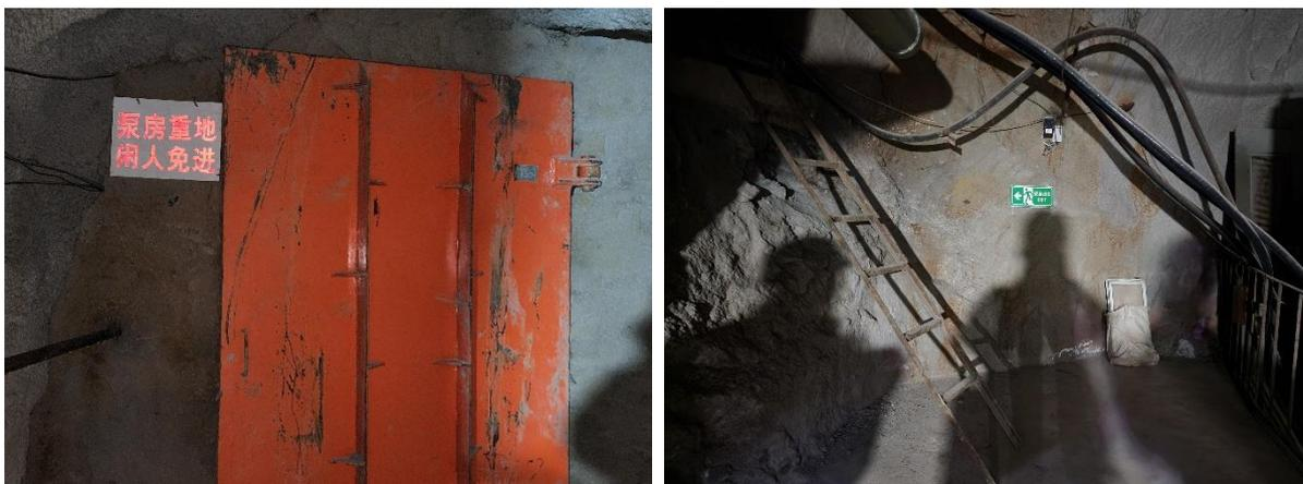
图 2.4-8 106m 中段（十七中段）段水泵站防水门及斜巷安全出口
