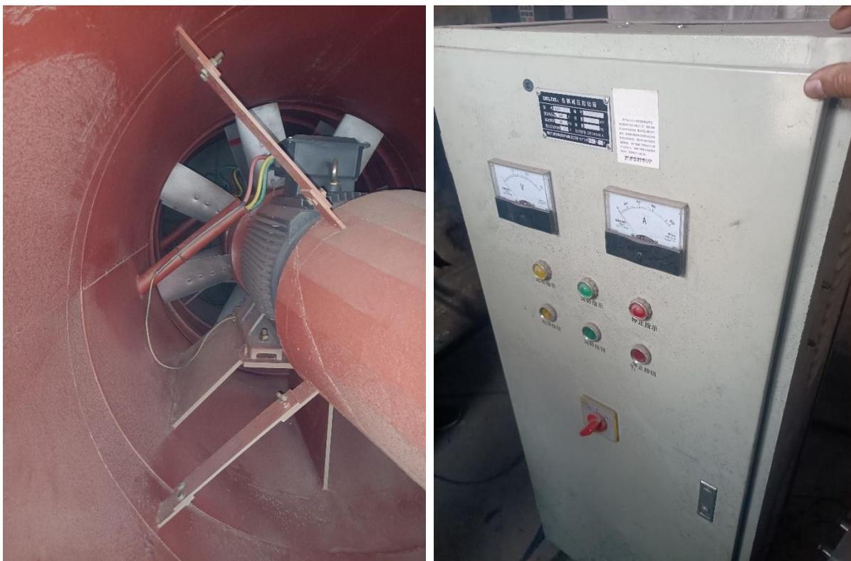
图 2.4-6 西风井风机备用电机和自动切换装置
