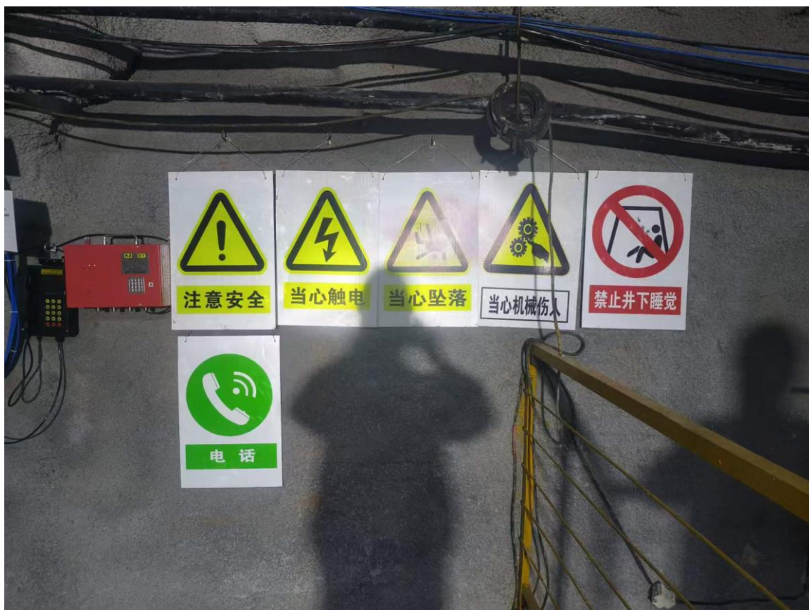
图 2-46 465m 中段水泵房安全标识
