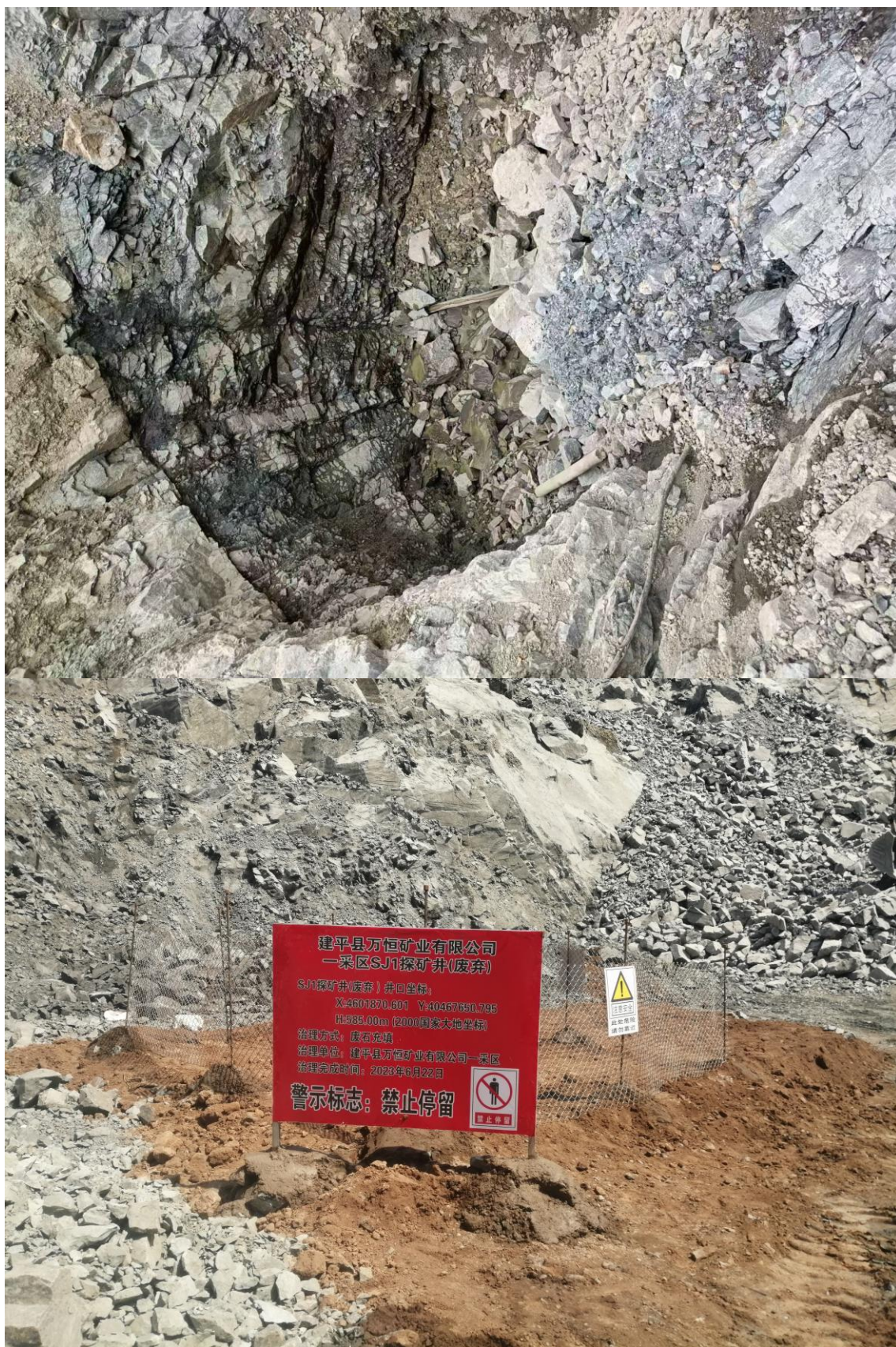
图 2-3 竖井回填隐蔽工程
