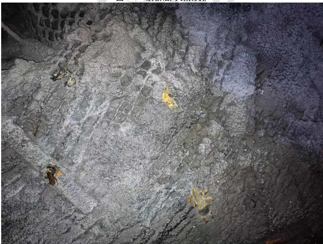
2-9 顶板锚网喷浆支护
