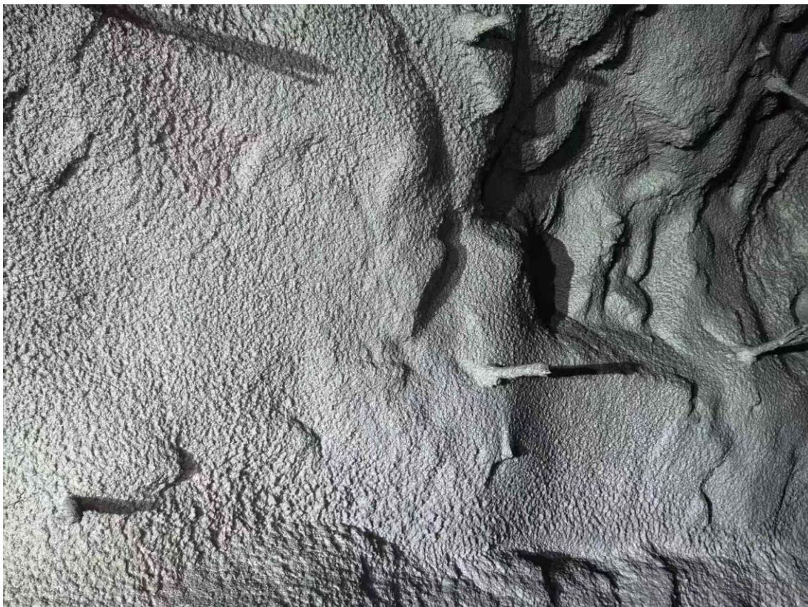
图 2-8 顶板锚网喷浆支护
